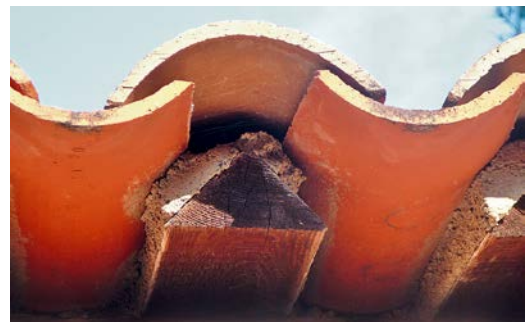
Abb. 2.30: Mönch- und Nonnenziegeldeckung
